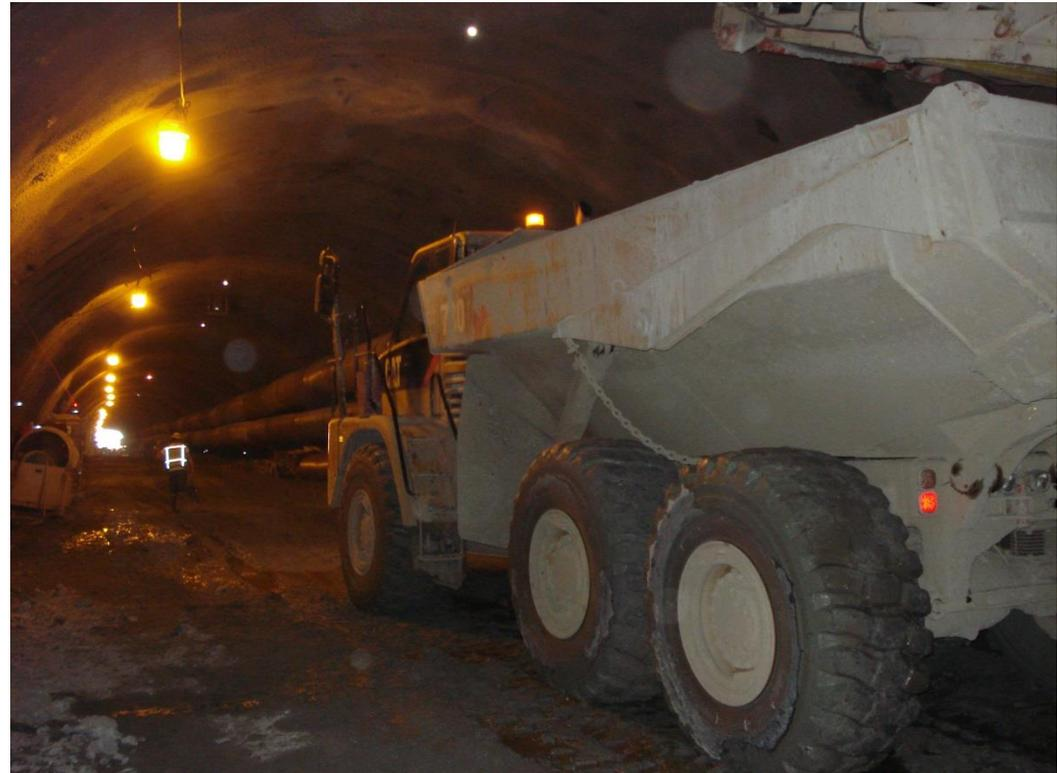
Im toten Sichtwinkel eines Baggers ist die Gefährdung, überfahren oder eingequetscht zu werden besonders groß. Videoüberwachung der blicktoten Räume ist eine mögliche Abhilfe.
